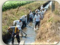
水路の泥上げ
