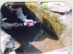
水路のひび割れ補修
