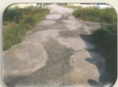
農道の窪みの補修
