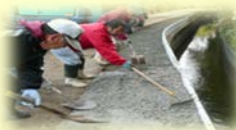
【水路の簡易補修】
