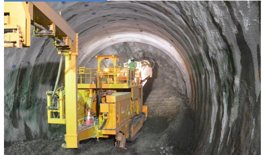
トンネル掘削状況
