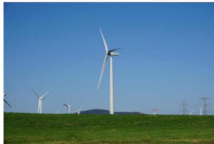
吹越台地風力発電事業（2015年）
