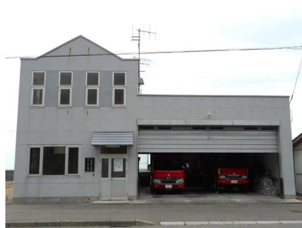
■熊石消防署相沼泊川分遣所
