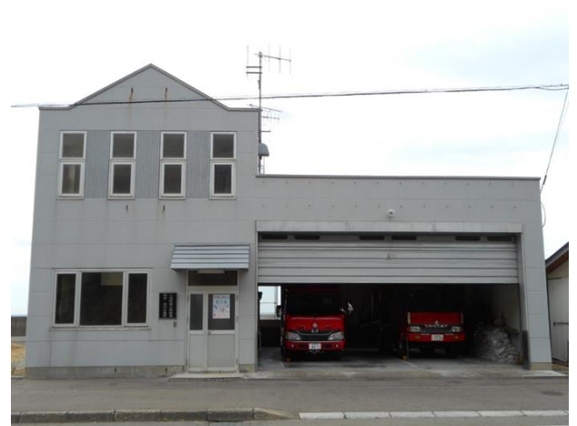
■熊石消防署相沼泊川分遣所
