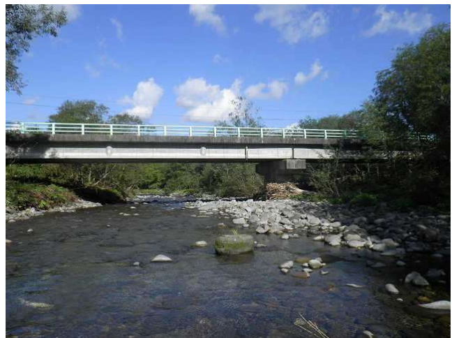
上遊楽部橋(橋長 60.2m) 1983年供用開始(36年経過)
