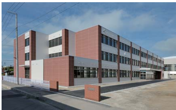
2013 (平成25) 年 7 月 26 日 八雲小学校新校舎完成
