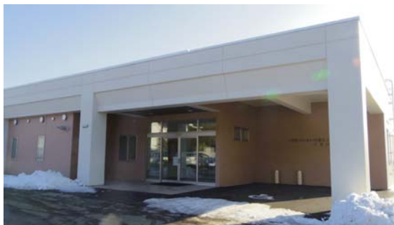
2015 (平成27) 年1月14日 ふれあい交流センター くまいし館完成
