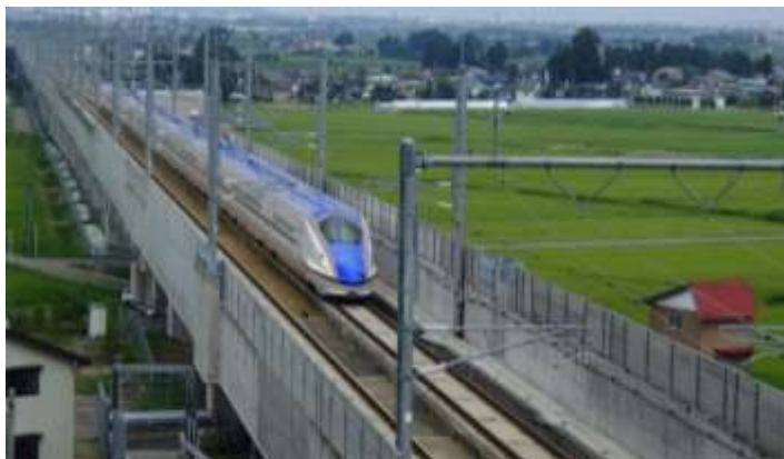
コンクリート製防音壁
